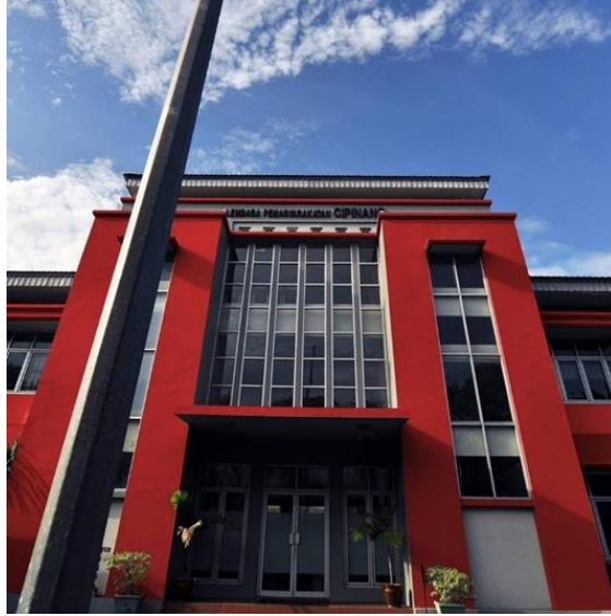
Gambar 1. Bangunan Lapas Kelas I Cipinang
